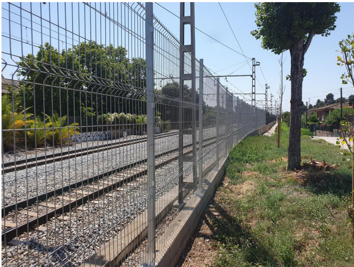
Nou tancament paral·lel a la via a Sant Vicenç dels Horts (línia Llobregat-Anoia).
