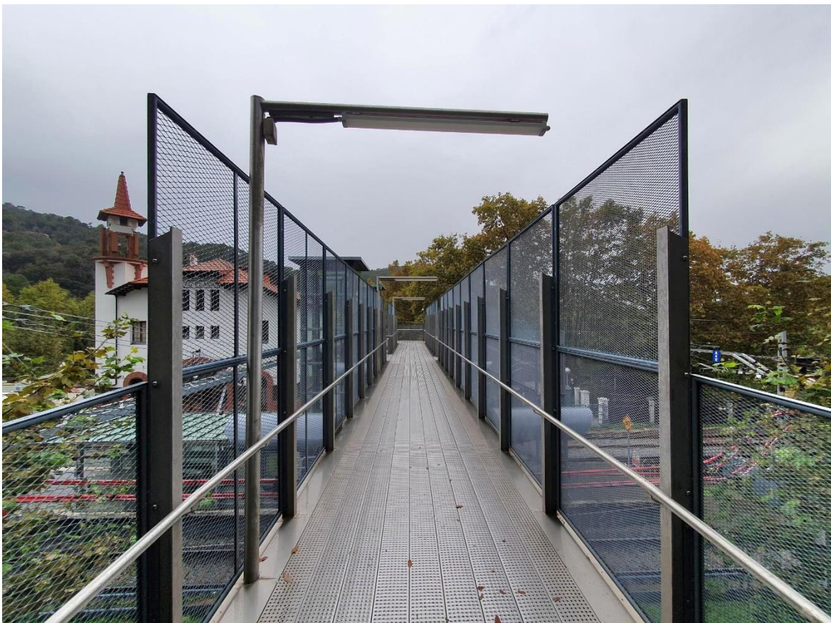
Noves tanques al pas superior de l'estació de Les Planes (línia Barcelona-Vallès).
