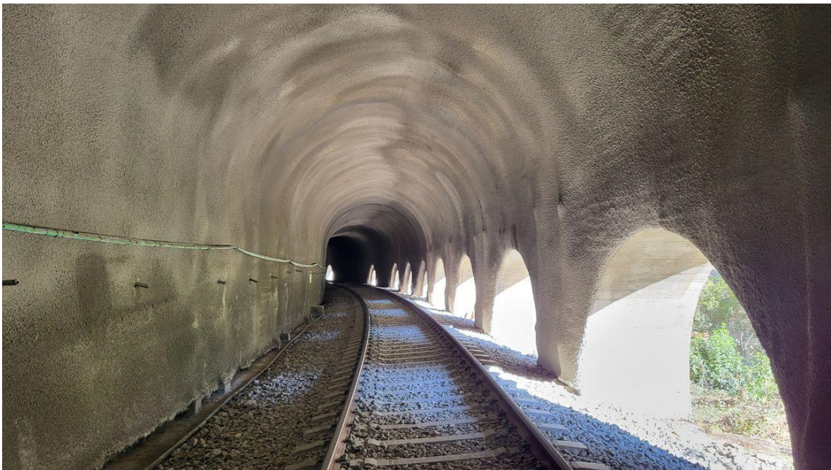
Aspecte del túnel renovat, situat al costat del pantà de Camarasa.
