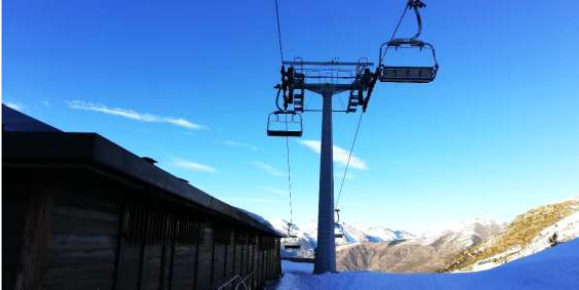
Figura 13. Imatges del TS4D Resort Express al costat del punt de restauració Carlina
