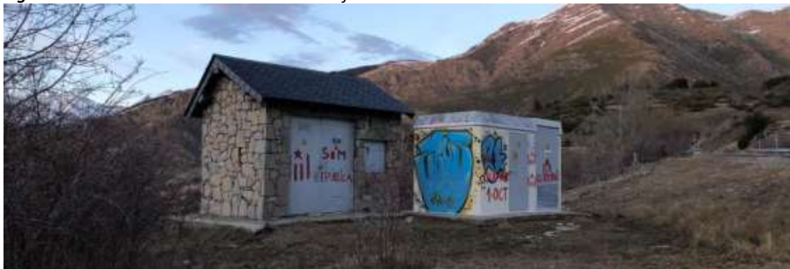
Figura 38. Caseta on s'inicia la línia elèctrica fins a l'estació de Boí Taüll
