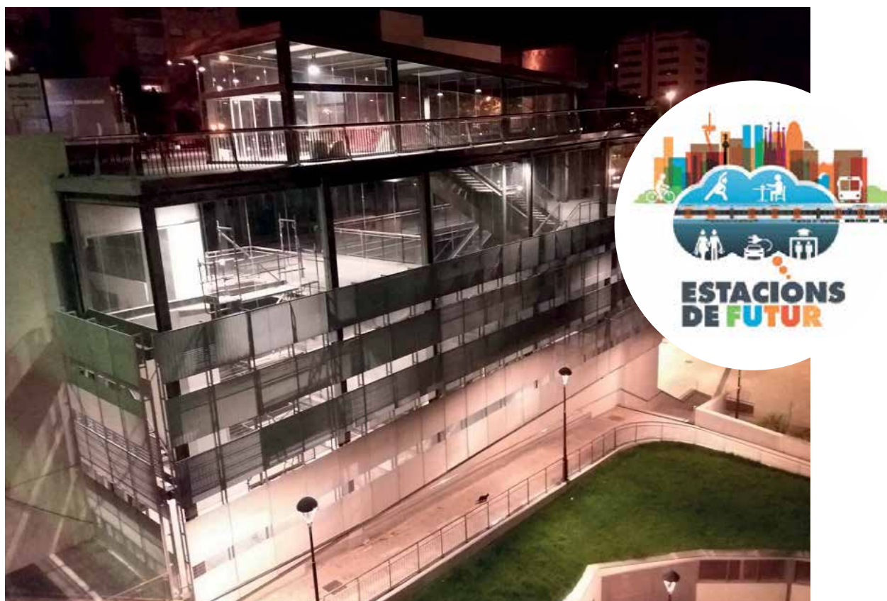
Estació de Vallparadís Universitat, a Terrassa. Integració de l'estació i el centre sanitari. Ofereix espais més amables, més accés, que és més progrés i més xarxa.
