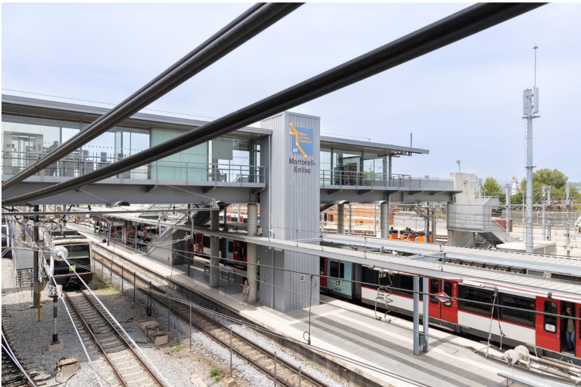
Estació de Martorell Enllaç d'FGC.
