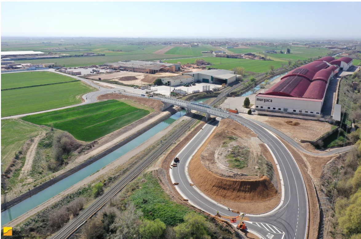
Imatge del nou pas elevat en substitució del pas a nivell 18, a Balaguer.
