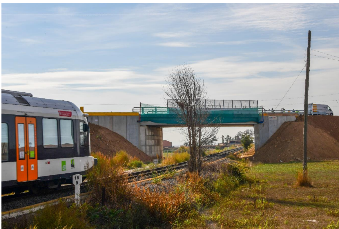
Imatge del nou pas elevat sobre la línia Lleida – La Pobla, a Tèrmens
