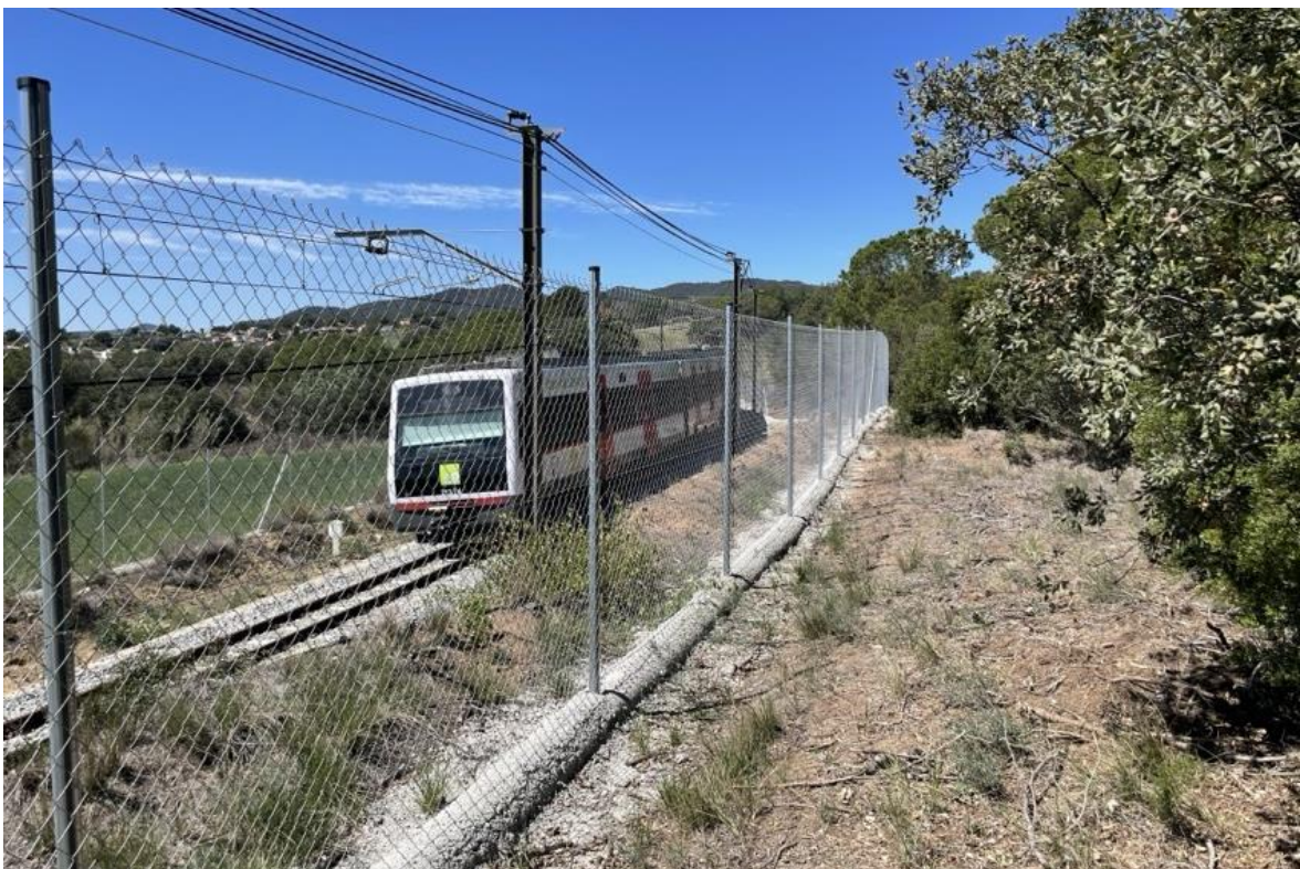
Tancaments de via amb base de formigó instal·lats entre Piera i Vallbona d'Anoia.
